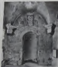
Fig. 12. SS. Quattro Coronati. South aisle wall, interior.
